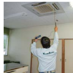
エアコンの点検
