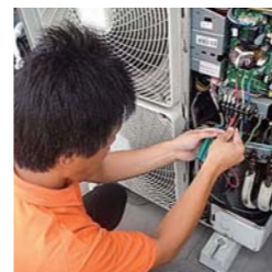
室外機の点検
