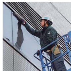
ビルのガラス清掃
