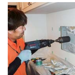
点検口設置工事
