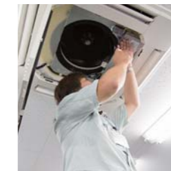
エアコンの設置工事
