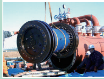
配管洗浄 PIG
